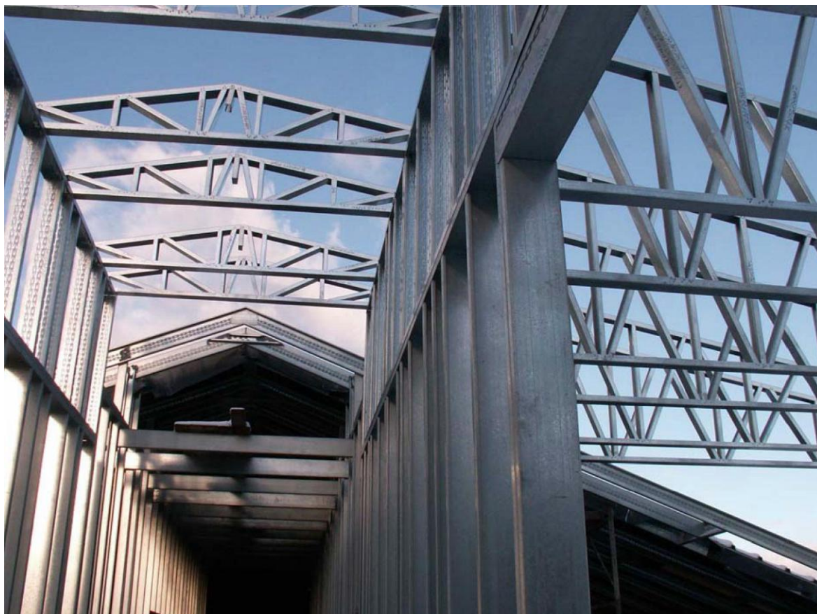
Рис. 2В. Каркас мансарды из термопрофиля в здании на 7-ой Красноармейской улице, г. Санкт-Петербург
