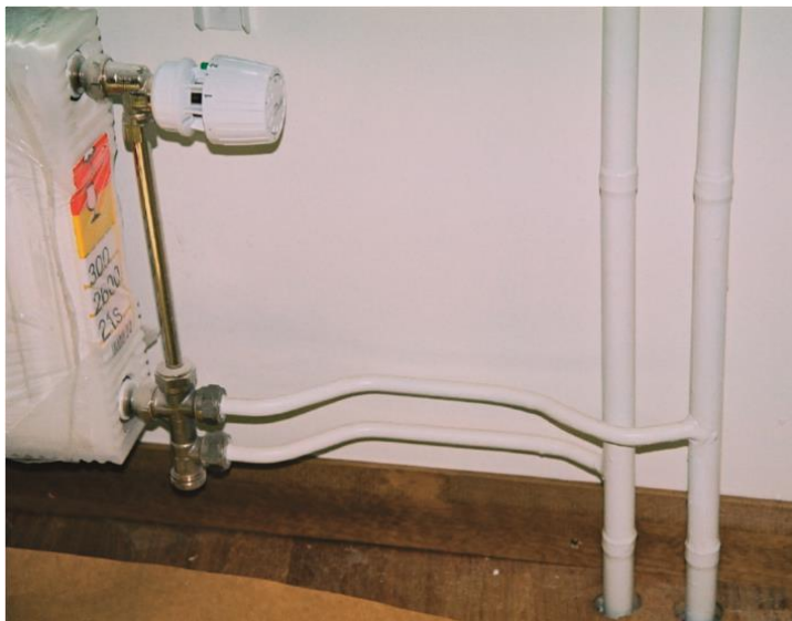
Рис. 28. Окрашенные медные трубы при открытой прокладке.
