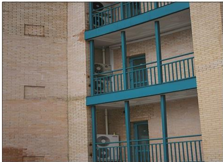
Рис. 30. Скрытое размещение наружных блоков в специально отведенных местах на наружных балконах
