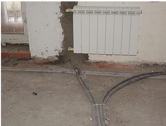
Рис. 22. Подключение отопительных приборов при лучевой разводке в полу
