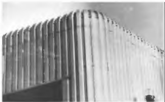
Рис.7.26. Фрагмент наружного ограждения здания с применением криволинейных профилированных листов системы «Кал-Цин» (Германия)
