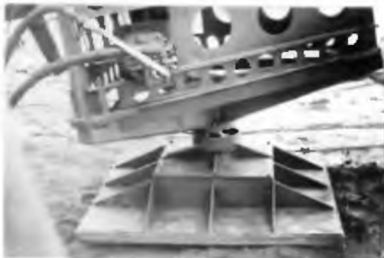
Рис.1.54. Установка ствола мачты на грунт
