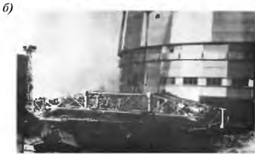
Рис.7.15. Здание астрономической обсерватории РАН a – общий вид; б – алюминиевая ферма забрала пролетом 12 м
