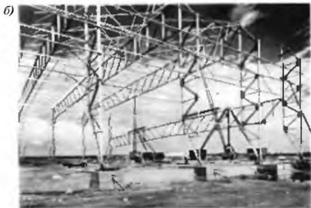
Рис.7.18 б. Ангар в Хэтфилде. Монтаж несущих конструкций
