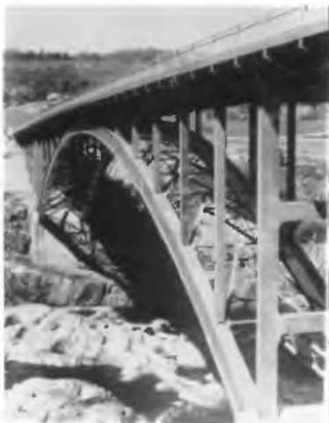
Рис.7.31. Мост из алюминиевых сплавов через р. Сегней с русловым пролетом 88,5 м (Канада)
