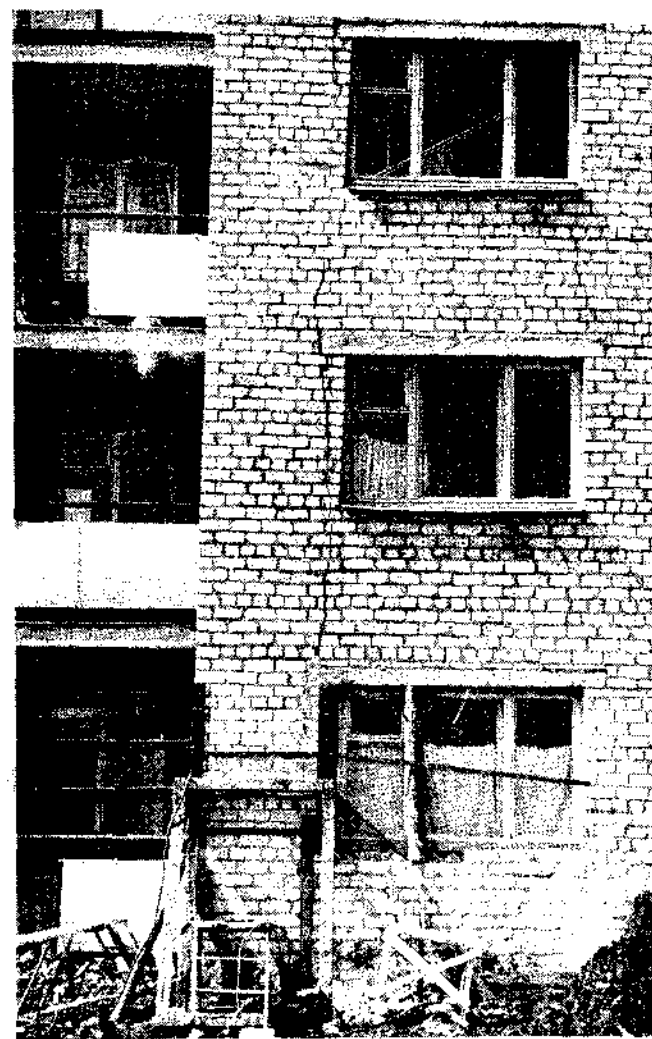
Рис. 132. Деформация здания от просадки в лессовой породе
