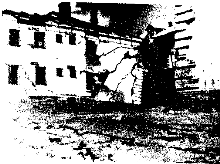
Р и с . 139. Разрушение здания на участке мульды
