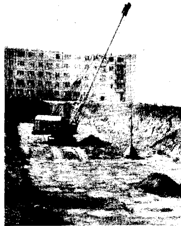
Р и с . 137. Трамбование просадочной лессовой породы
