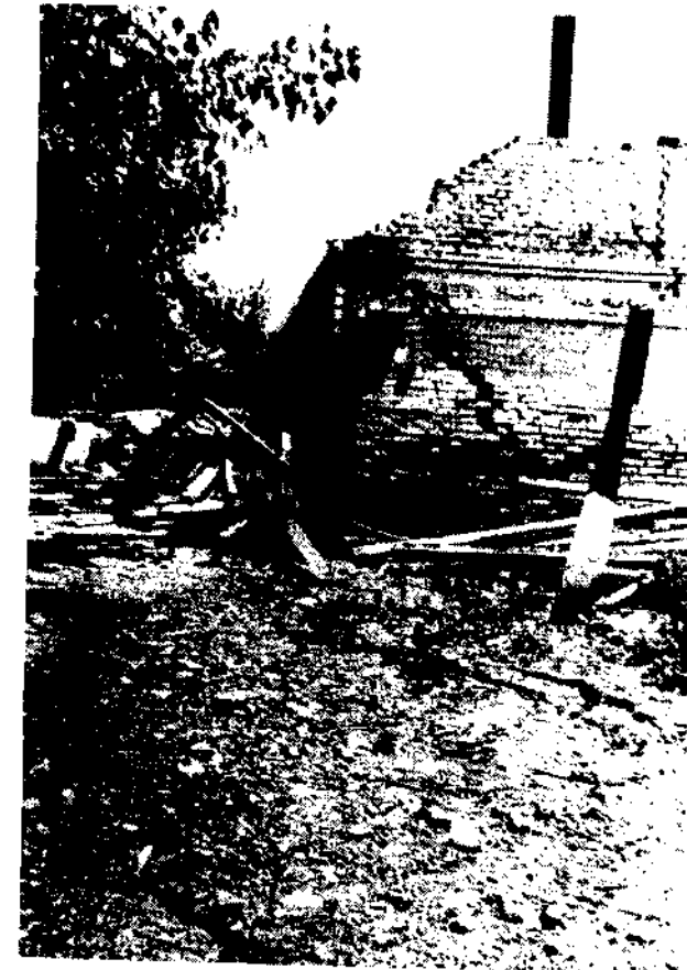
Рис. 115. Деформация здания от оползня
