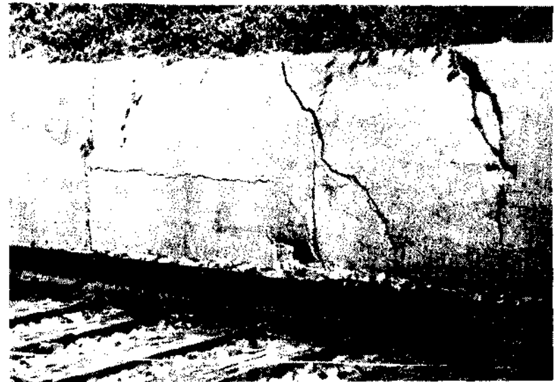
Р и с . 122. Деформация подпорной стены в подошве оползня
