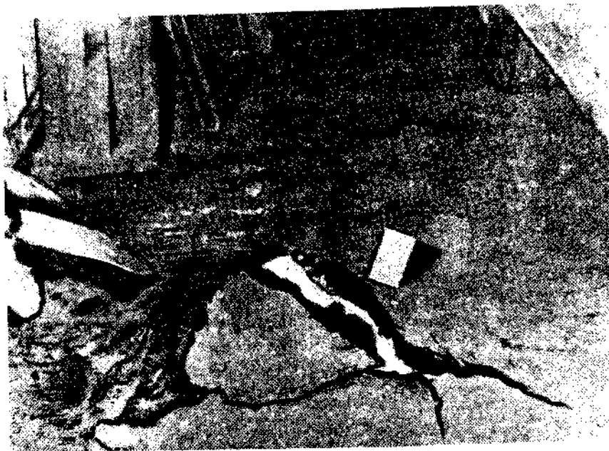
Рис. 74. Разрушение асфальтового покрытия в результате роста грибов
