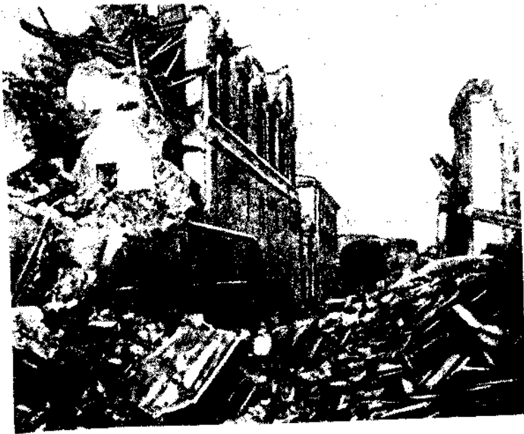
Р и с . 22. Разрушения в городе в результате землетрясения
