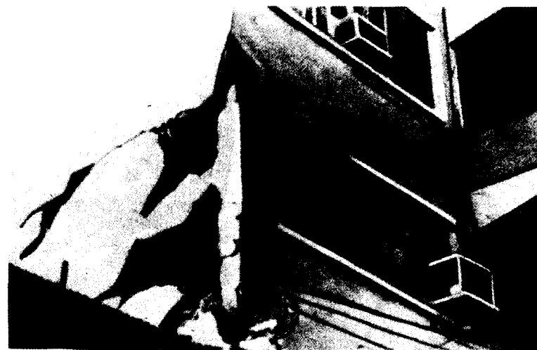
Рис. 9-1. Повреждение здания Ланг Билдинг в результате соударений во время землетрясения в Манagua, 1972.
