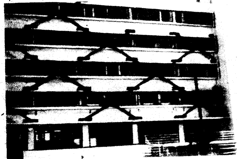
Рис. 8-15. Разделение балки с колонной для восстановления конструкции после землетрясения в г. Сендай, 1978, в здании Технологического института Токоху а — вертикальный разрез; б — сечение; в — фотоснимок фасада
