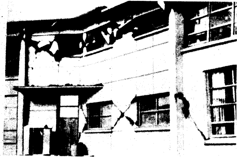
Рис. 6-5. Высшая школа в г. Анкоридж. Повреждение диафрагм в месте пересечения крыльев здания
