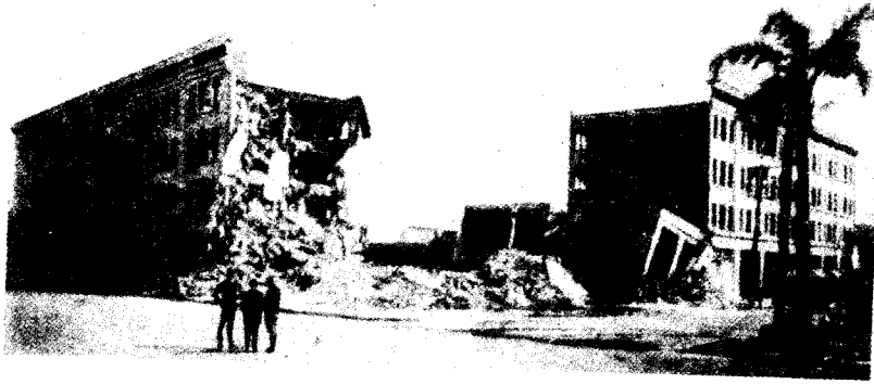
Рис. 6-6. Разрушение входящего угла здания Сан-Маркос, землетрясение в г. Санта-Барбара, Калифорния, 1925
