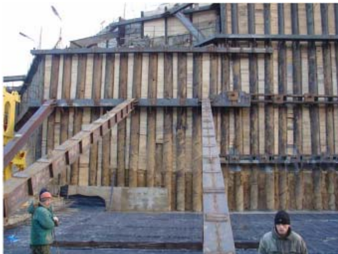
Рис. 2.20. Пример подкосной ( a ) и подпорной ( б ) систем
