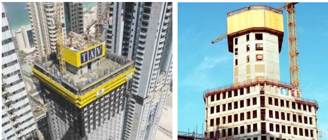
Рис. 3.3. Самодвижущаяся опалубочная платформа
