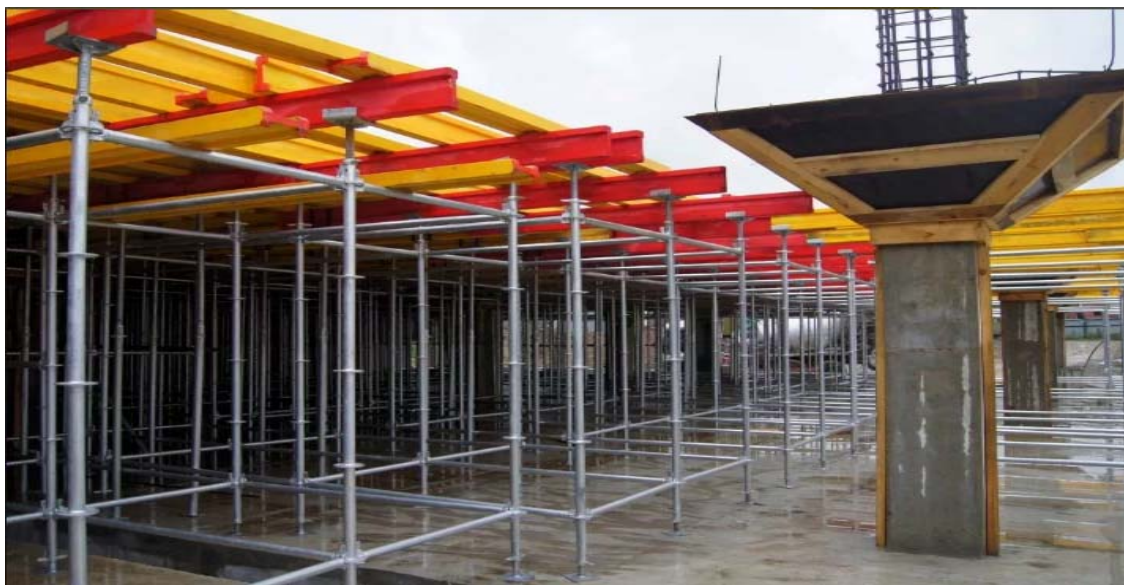
Рис. 3.10. Опалубки перекрытий на объемных стойках
