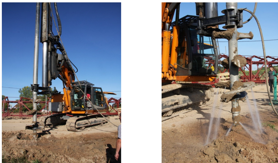
Рис. 2.13. Оборудование для реализации буросмесительной технологии
