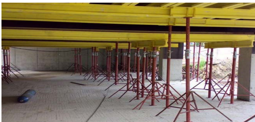
Рис. 3.9. Опалубка перекрытий на телескопических стойках
