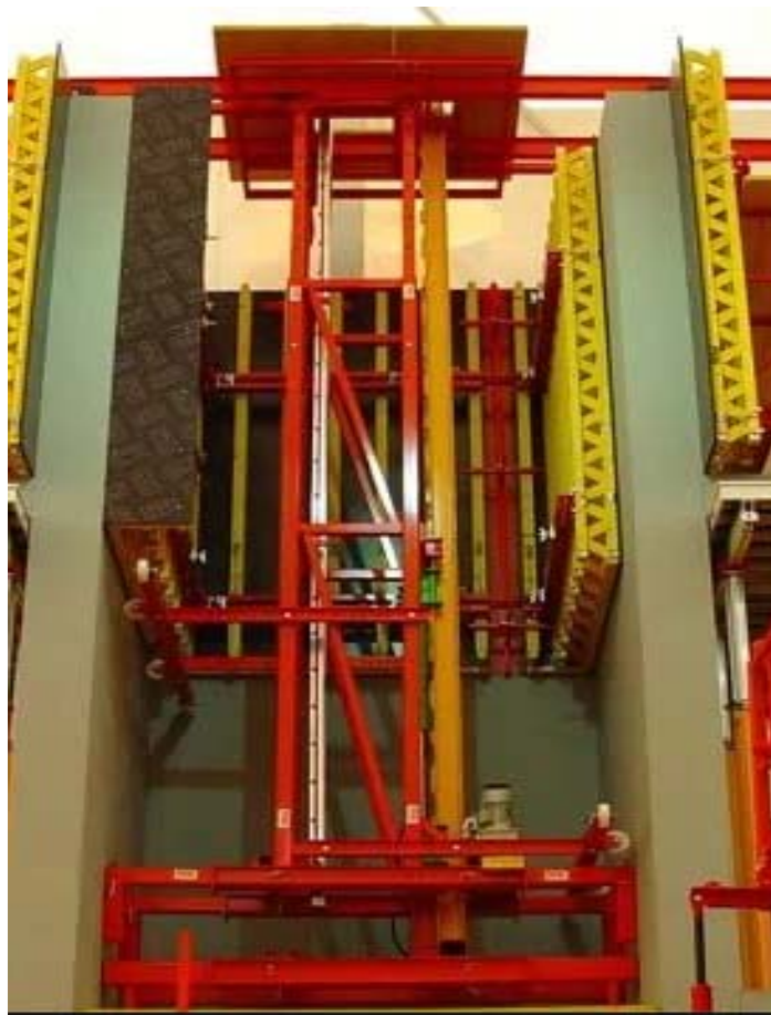
Рис. 3.4. Система самоподъемная ACS [22]
