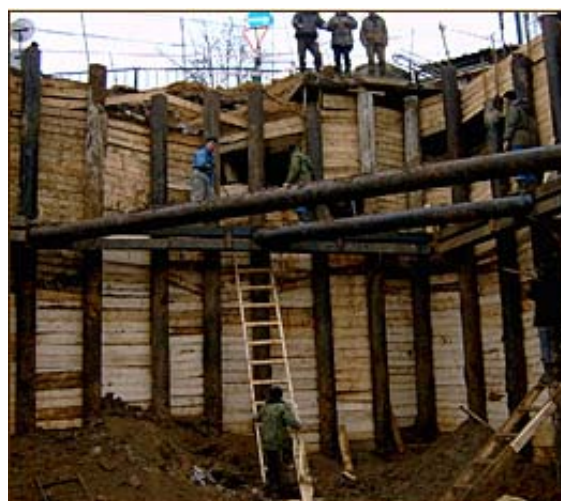
Рис. 2.20. Пример подкосной ( a ) и подпорной ( б ) систем
