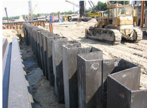
Рис. 2.6. Шпунтовое ограждение котлована
