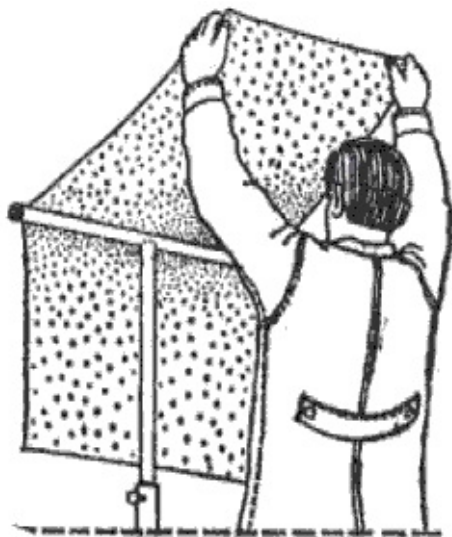
Рис. 190. Приспособление для наклейки обоев на потолок
