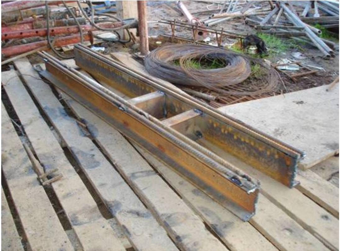
Рис. 1 Закладная деталь распределительной системы (по Л.Л. Кукше)
