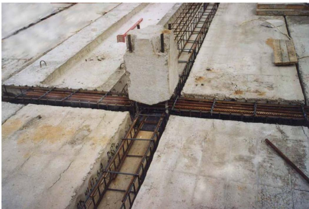
Рис. 2.1 Фрагмент сборно-монолитного каркаса серии Б1.020.1-7
