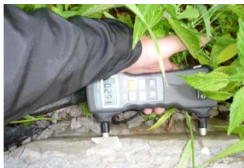
Рис. 2.19. Определение прочности бетона неразрушающим методом с использованием ультразвукового сканера
