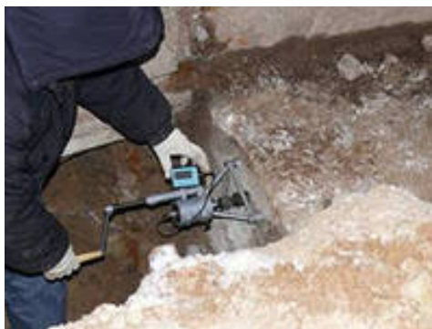
Рис. 2.16. Определение прочности бетона методом отрыва со скалыванием
