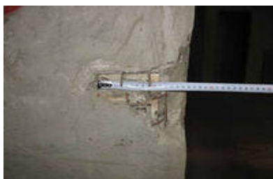
Рис. 2.22. Вскрытие конструкции с целью определения наличия, шага и диаметра арматуры
