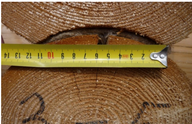
Рис. 3.15. Замеры толщины швов между венцами бревенчатой стены
