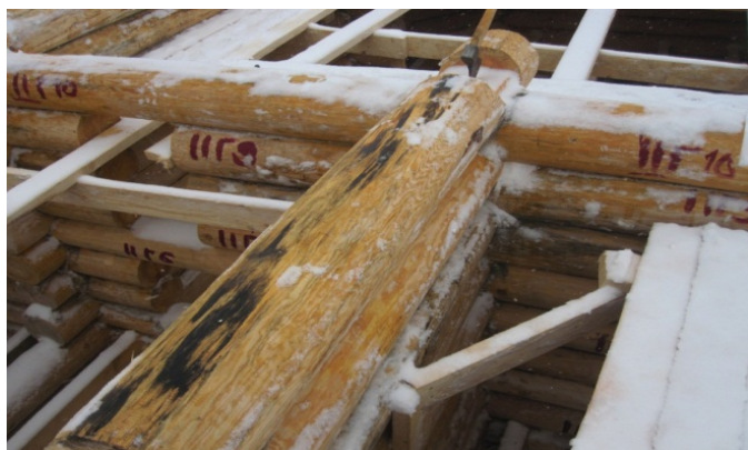
Рис. 3.16. На поверхности бревна видны следы гниения
